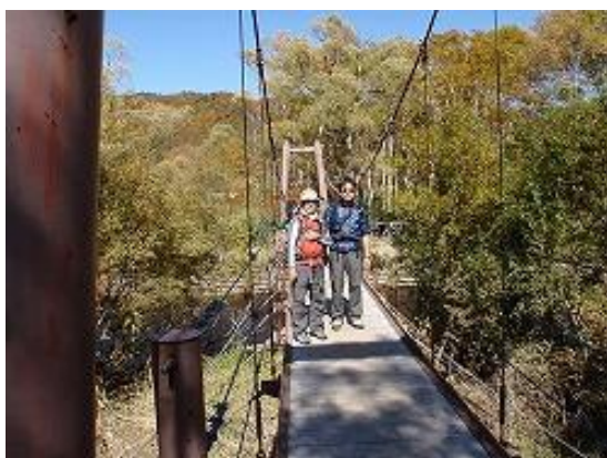
ヨッピー吊り橋
