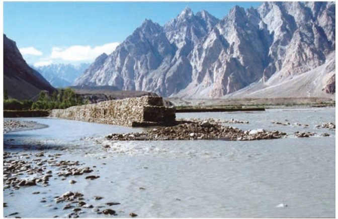
完成した当時の護岸堤
