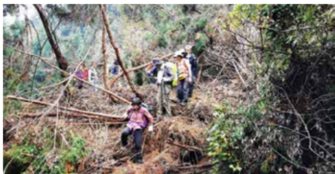
林道が土砂崩れ
