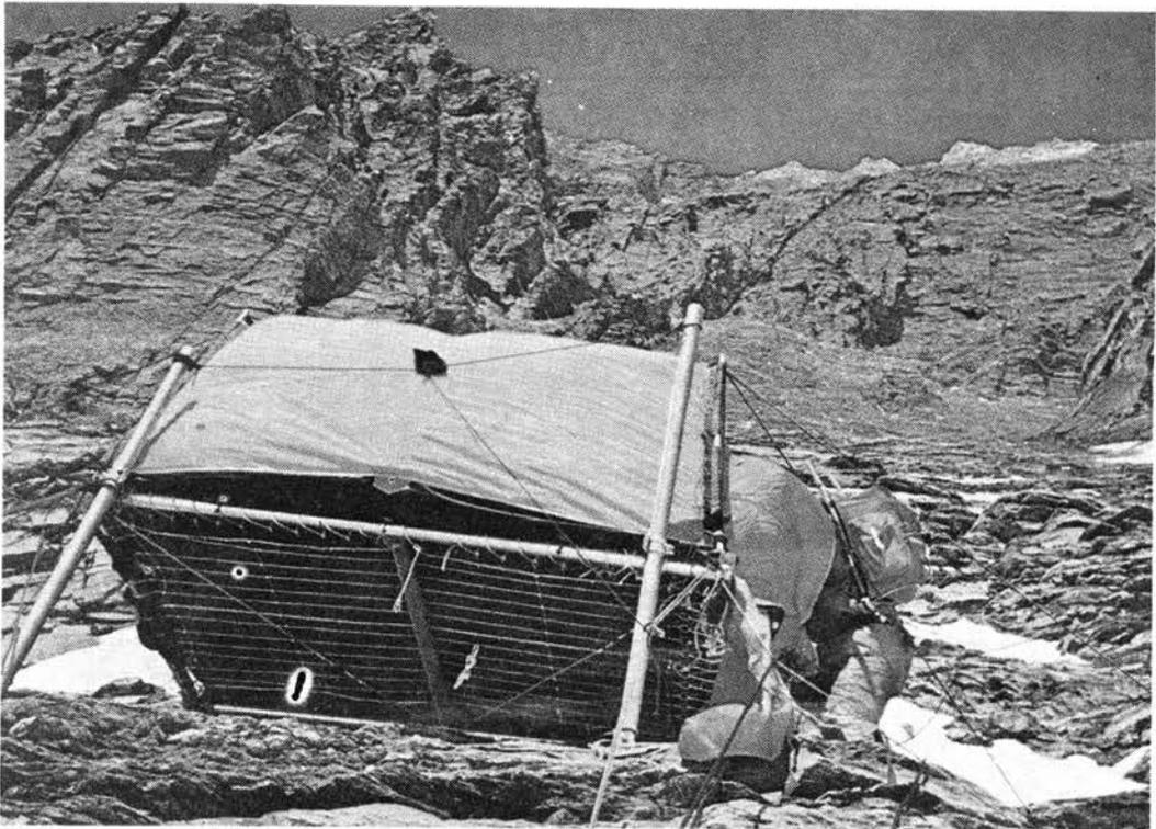
第5図 南壁第4キャンプ(7,500m)に使用された人工キャンプ台
