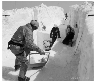
写真① 雪庇の断面を観察するため掘り進める作業
