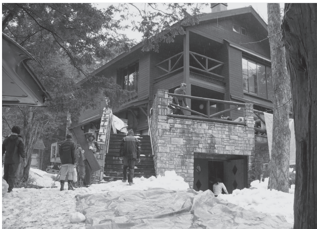
まだ周囲に残雪が残るなか、開所作業が進む
