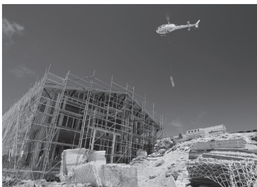
再建が進む二ノ池山荘(旧・二ノ池本館)の建設現場
