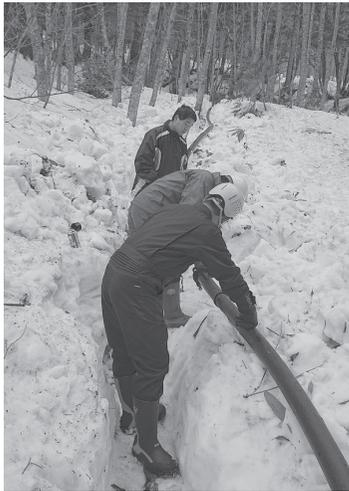
残雪の下に埋もれている導水管を掘り起こす作業
