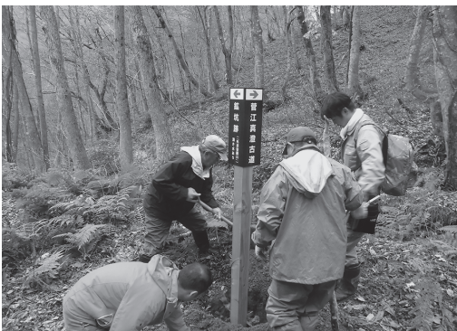
地元役場の職員をはじめ有志が地面に穴を掘り、道標を立てた
