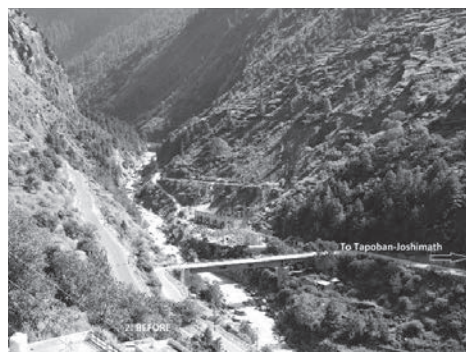
被災前のタポバン・ダム(上)と、同・リシ・ガンガ発電所(Raj Kumar Khosla 氏、2019年9月撮影・提供)
