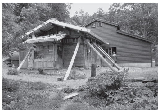
再施工後の徳本峠小屋(手前が休憩棟、奥が宿泊棟) 2010年7月10日撮影
