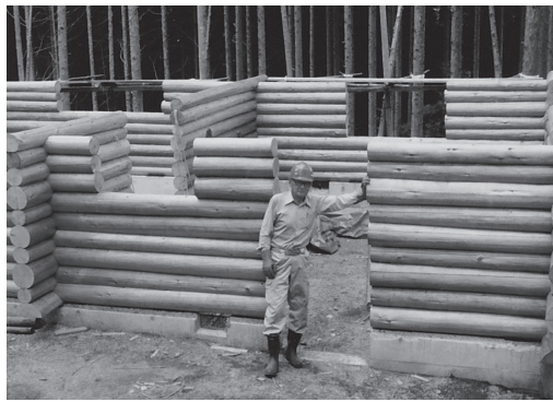
ログハウスを建設中の荻野恭一会員
