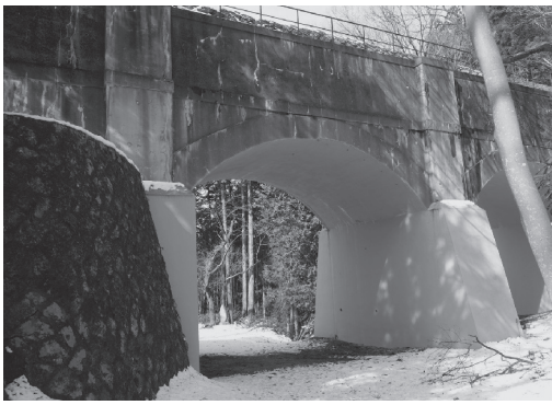
どことなく異国情緒が漂う水路橋(ピーヤ)
