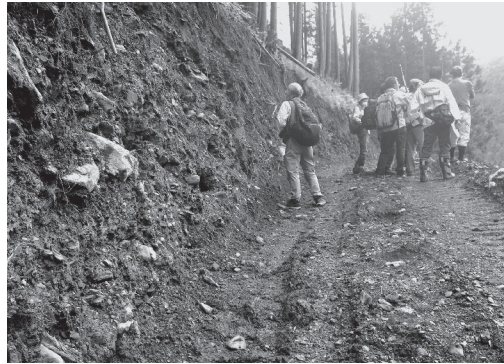
斜面の岩くず堆積物(将来崩れる可能性がある)
