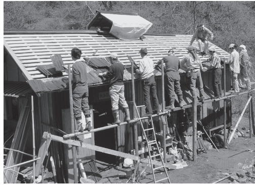
屋根の葺き替え作業
