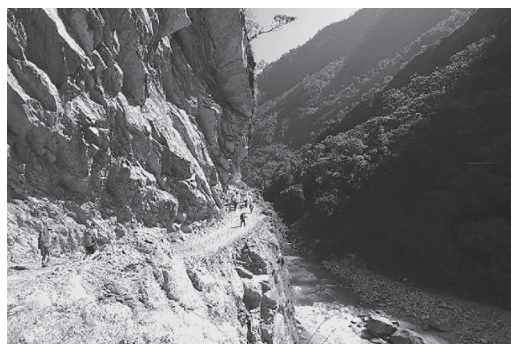
ブリ・ガンダキ峡谷の岩壁を削って車道が奥地まで進む。ジャガット付近にて
