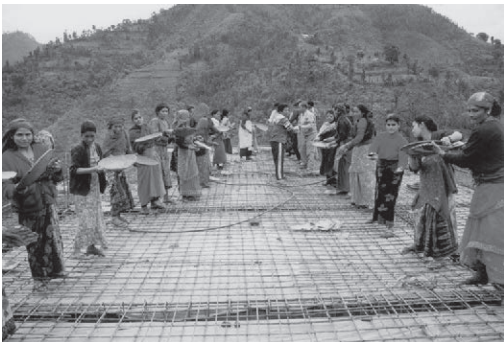
タンセン地方ドゥムレ村に建設中の校舎の屋根にコンクリートを流す作業は、雨期に村人総出で行なわれた。2000年6月
