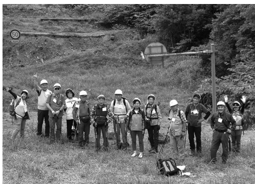
C班:地盤隆起で階段状になった国道230号。西山山麓にて
