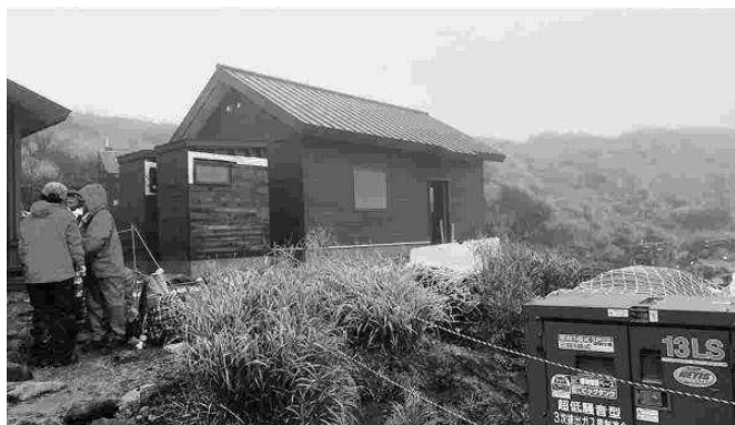
新しい避難小屋と携帯トイレブース2棟(左側) (写真 磯野文雄)
