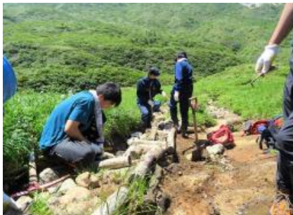
木道の補修作業
