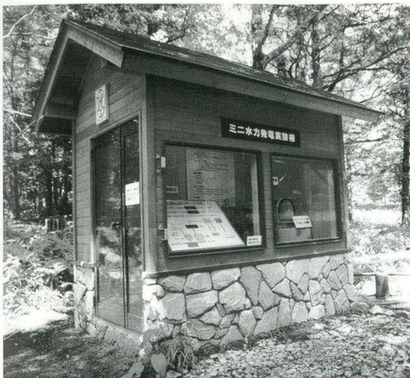
2000 (平成12) 年5月に完工した上高地山岳研究所に隣接する「ミニ水力発電装置」 Miniature Hydroelectric Generation at SANKEN in Kamikochi
