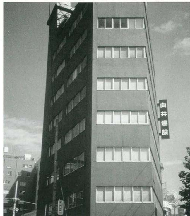
1967 (昭和42) 年、神田錦町の「向井ビル」 MUKAI Bldg. in Kanda in 1967
