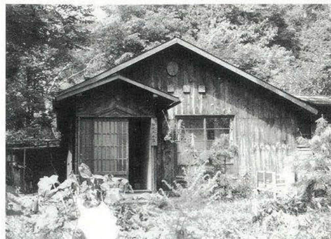
1961(昭和36)年ごろの「山研」。当時は「神河内山荘」と呼ばれていた "SAN-KEN", the Alpine Research Hut in Kamikochi around 1961
