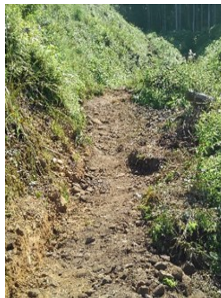
3. 土をかぶせて完成
