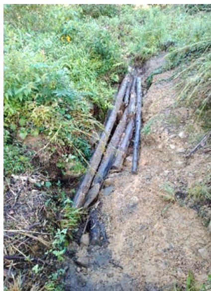
1. 深く削られた登山道 仮の足場の丸太を取り除く
