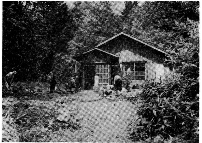
流出した土砂に道路を埋められた旧山荘
