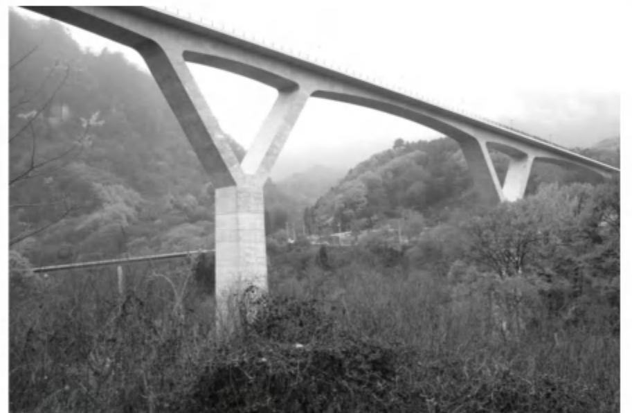
完成した県道横壁線の橋梁
