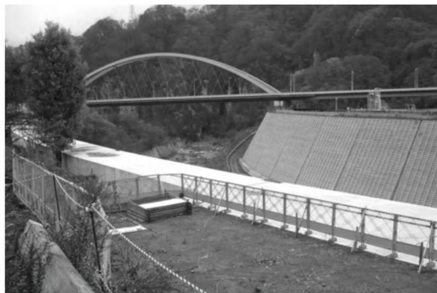
完成した橋と増水時を想定した護岸工事
