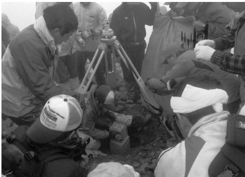
方角、水平の微調整をしながら標石を立てる
