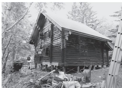
修復工事中の空沼小屋
