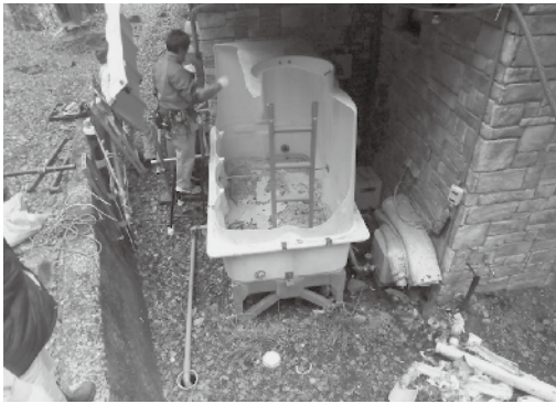
解体中の従来の受水槽
