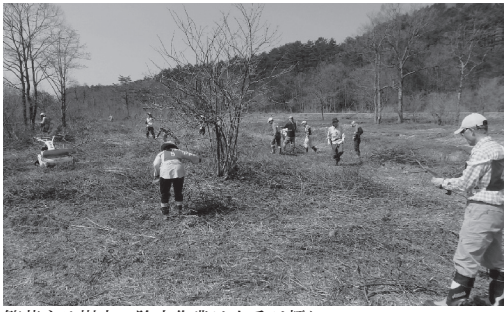
繁茂する樹木の除去作業は人手が頼り
