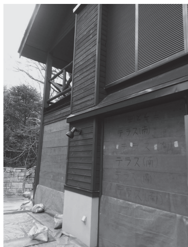
雪囲いで封鎖された玄関とバルコニー
