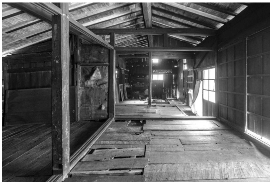
整理した後の室内の様子。東面の寝室の一部
